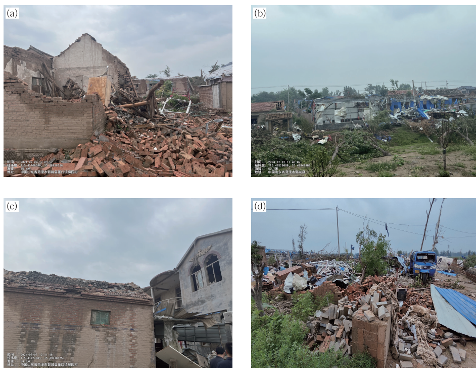
图 8 2024 年 7 月 5 日山东鄄城县龙卷造成(a~c)柳园村(a)房屋倒塌、 (b)钢结构建筑损毁、(c)房屋受损,以及(d)西王潭村房屋损毁
