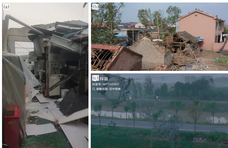
图 2 2024 年 7 月 5 日山东东明县龙卷造成(a)蔡坡村北塑料制品公司厂房损毁,(b)沙河村民房倒塌,(c)高堎村附近高压线塔倾倒
