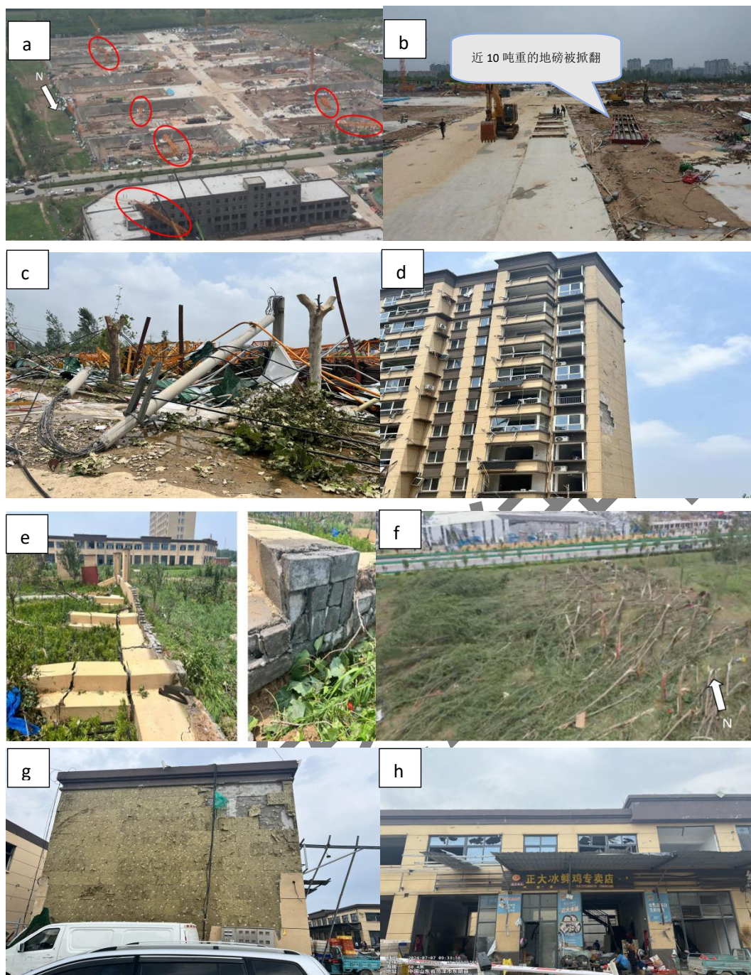
图4 2024年7月5日东明县龙卷造成的(a, b, c)建筑工地, (d, e, f)白寨小区, (g, h)白寨小区西侧农贸市场的受灾情况
