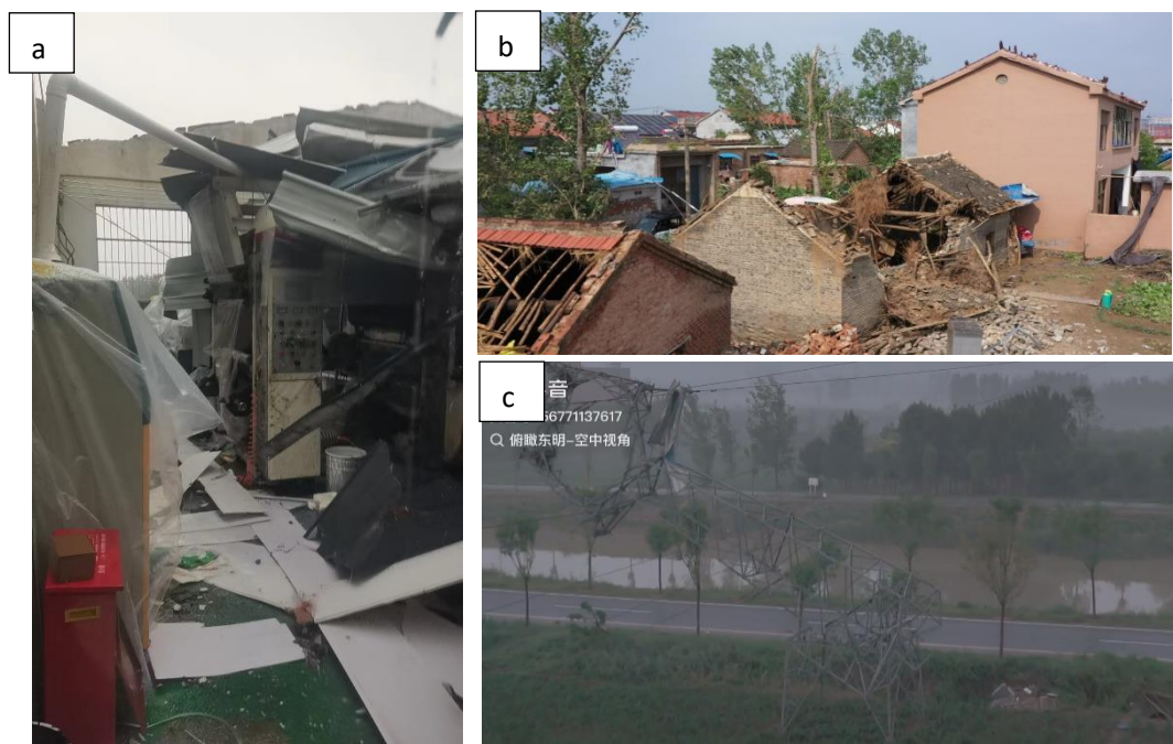
图2 2024年7月5日东明县龙卷造成的（a）蔡坡村北塑料制品公司厂房损毁，（b）沙河村民房倒塌，（c）高钊村附近高压线塔倾倒
