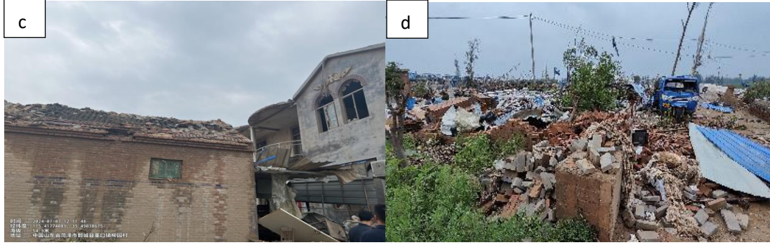
图 8 2024 年 7 月 5 日鄆城县龙卷造成的柳园村 (a) 房屋倒塌、(b) 钢结构建筑损毁、(c) 房屋受损和 (d) 西王潭村房屋损毁
