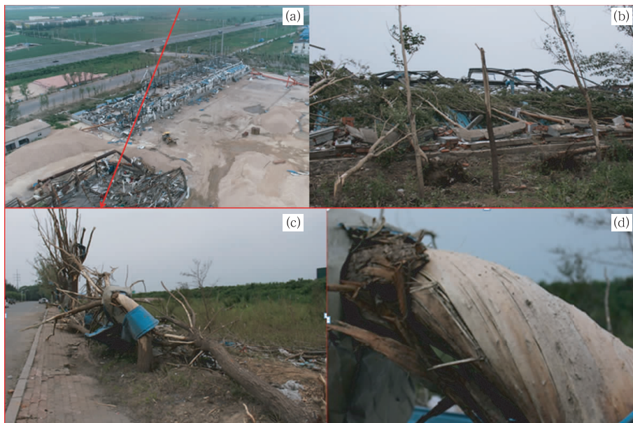
图 6 龙卷路径(a)及钢架厂房(b)和硬木大树(c,d)损毁情况
