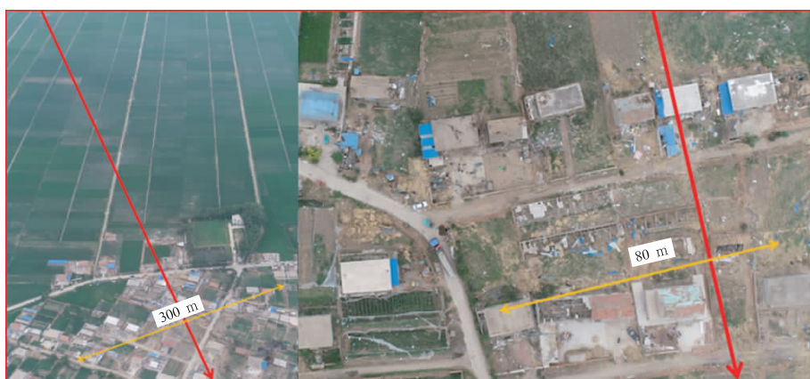
图 3 无人机航拍金英村及北侧龙卷建筑和植被损毁情况及轨迹
