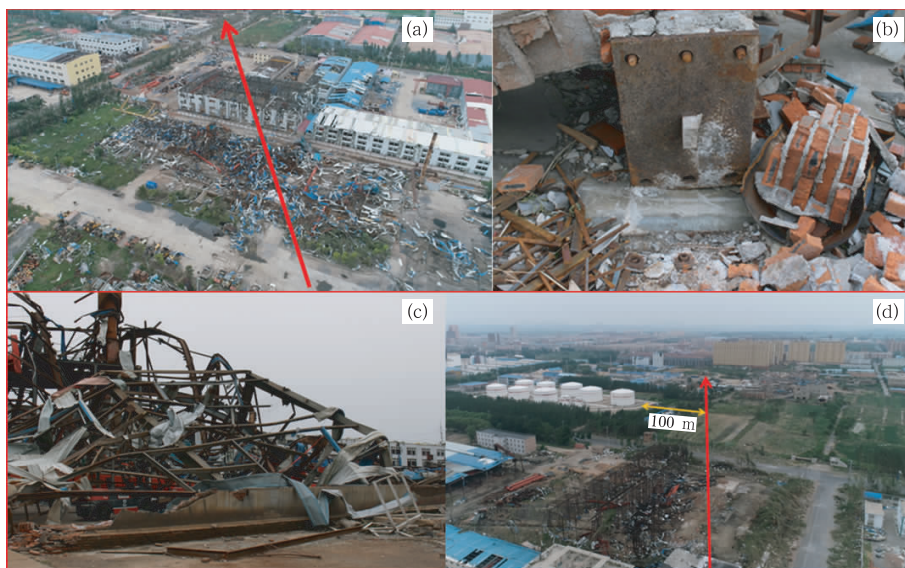
图 7 大型钢架厂房全毁(a, b, c)和距离龙卷路径中心 100 m 储油罐(d)
